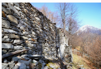
Mit Ihrer Hilfe wiederaufgebaute Trockenmauern!
