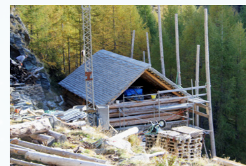
Die Hütte auf der Fontana-Alp heute! Ein Meisterwerk!
