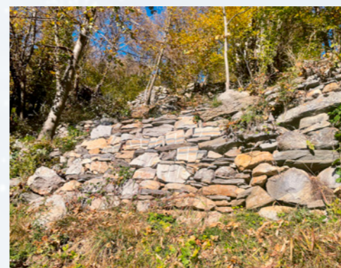
Nachher: Wieder aufgebaute Trockenmauern, abtransportiertes Holz!
