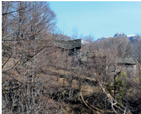
Baufälliges Haus hinter der Vegetation
