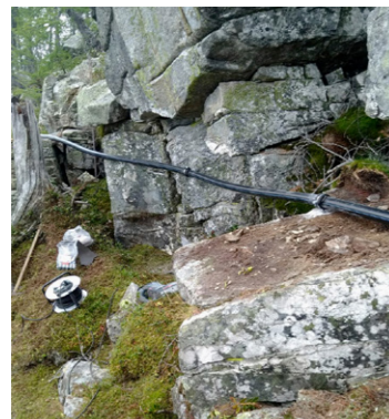
Verlegung der Wasserleitungen
