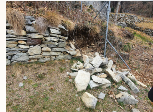
Eingestürzte Trockenmauer
